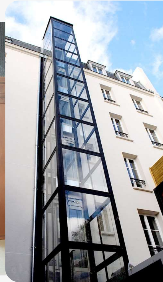
Edificio sin ascensor
