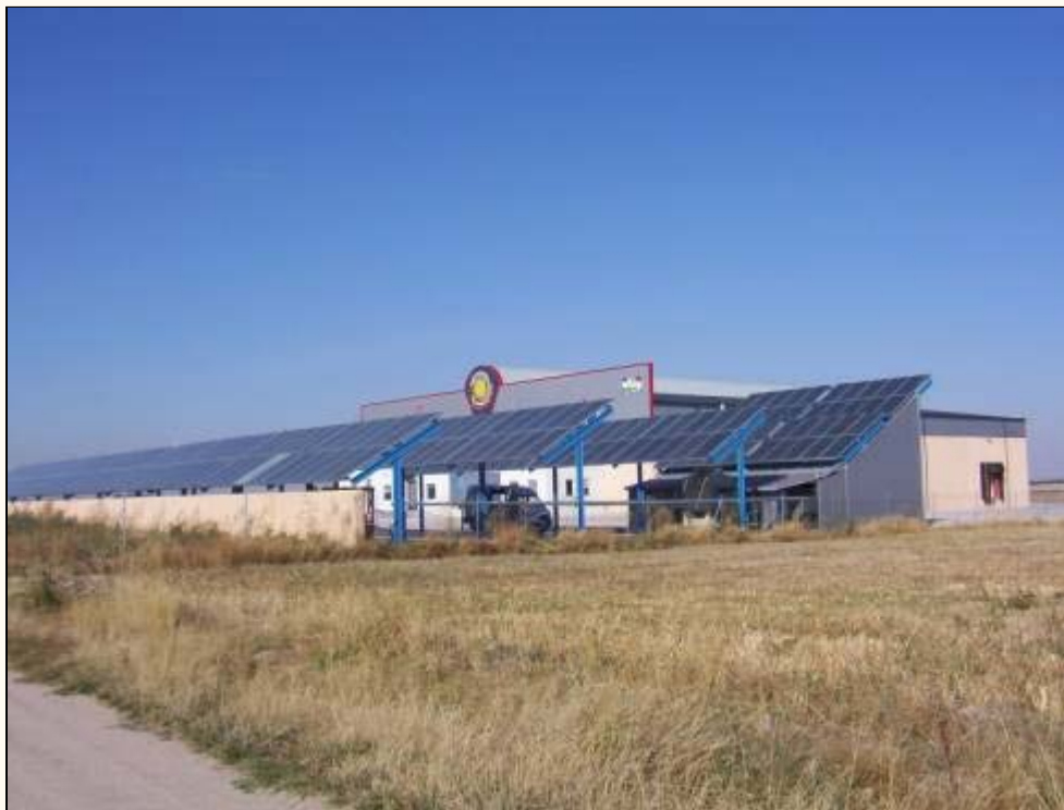
Vista general del campo de captadores
