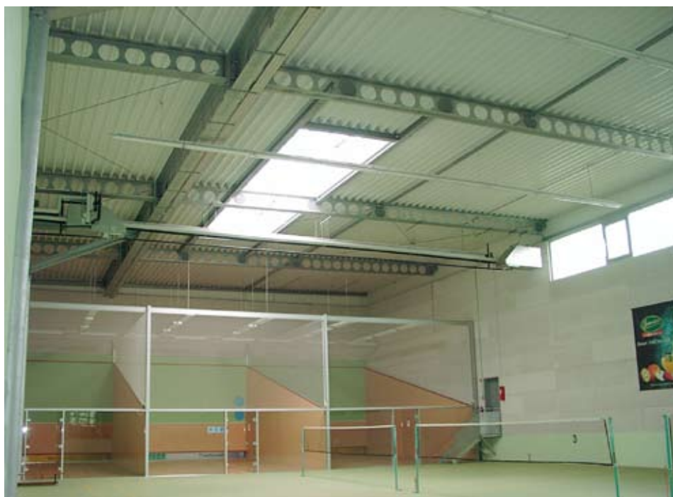
Figura 1: Viga ACB® de cubierta
