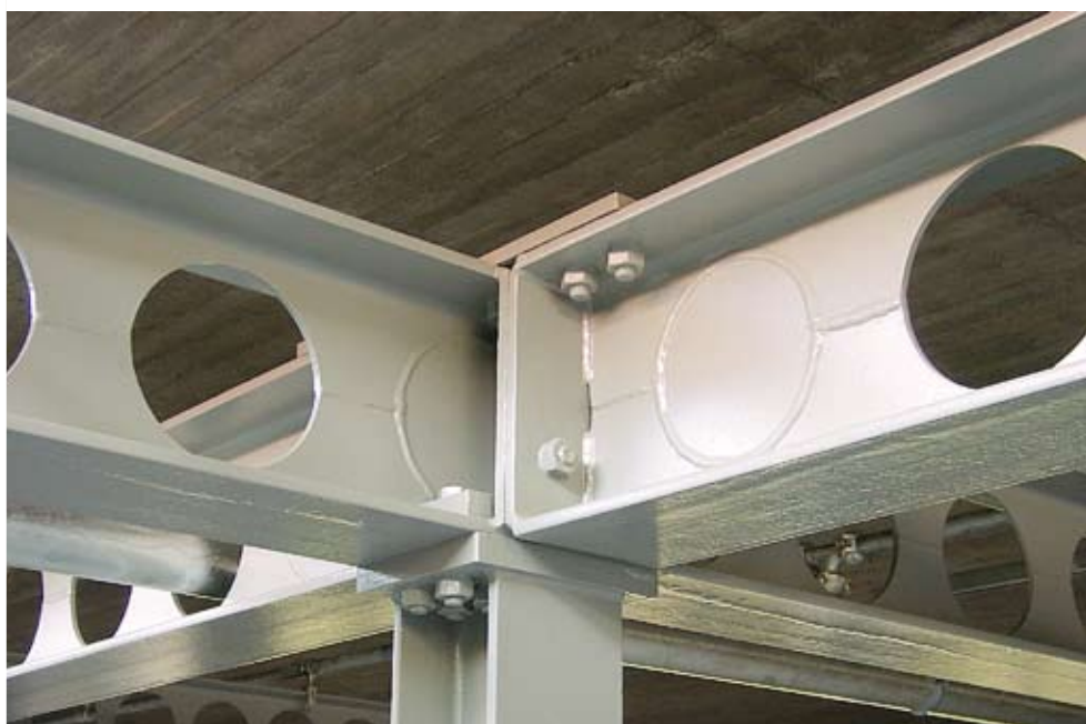
Figura 11b: Ejemplo de viga ACB® con alveolo reforzado
