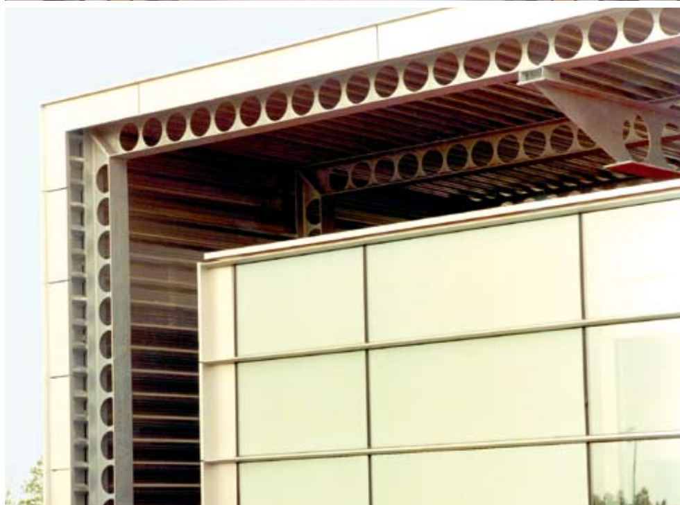
Figura 3: Combinación de viga-pilar ACB®
