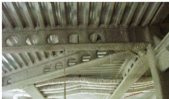
Figura 31: Protección mediante aplicación de mortero en una viga ACB®
